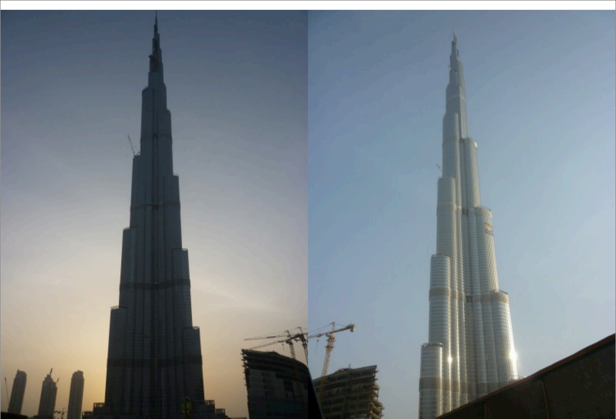
世界一の高層ビル Burj Dubai (828m)
